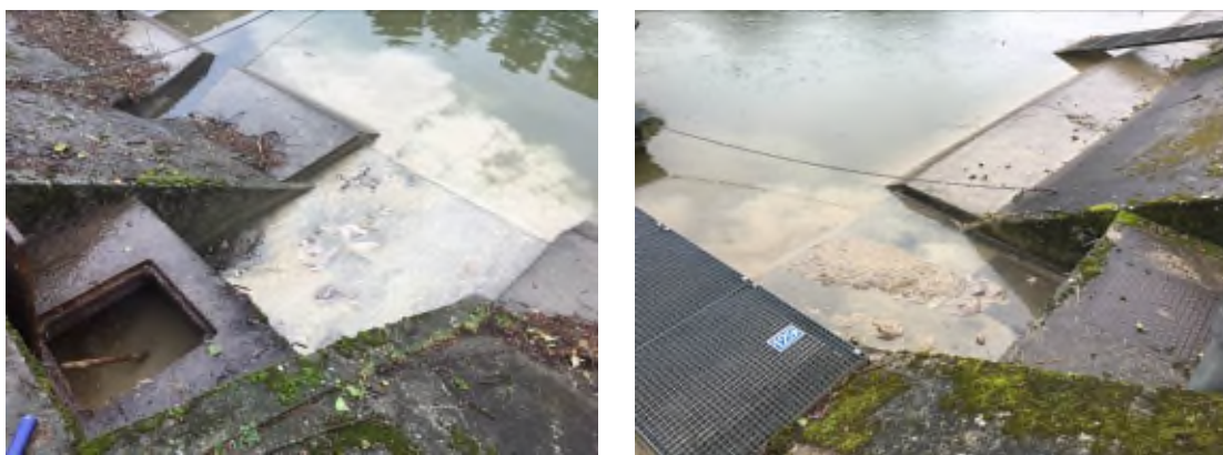
Dysfonctionnement du 8.03.2017 (déversoirs Thièle)
