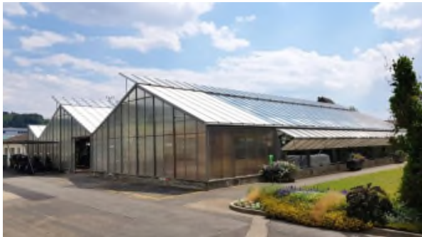
Serres construites en 1986
